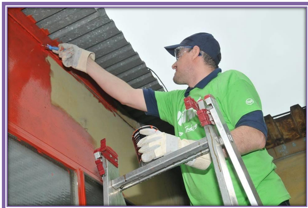
Maľovanie okennej kovovej konštrukcie vo vnútornom dvore
