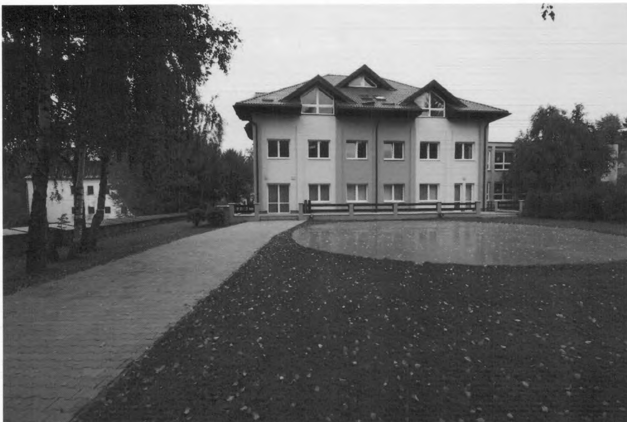
Budova kultúrneho domu po rekonštrukcii
