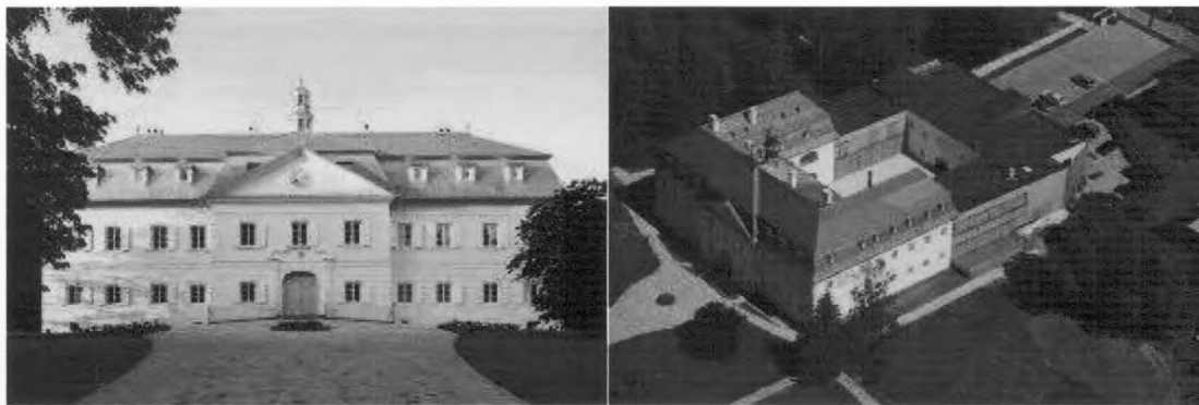
Hotel po rekonštrukcii
