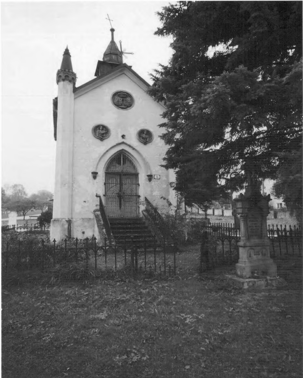
Kaplnka pred rekonštrukciou
