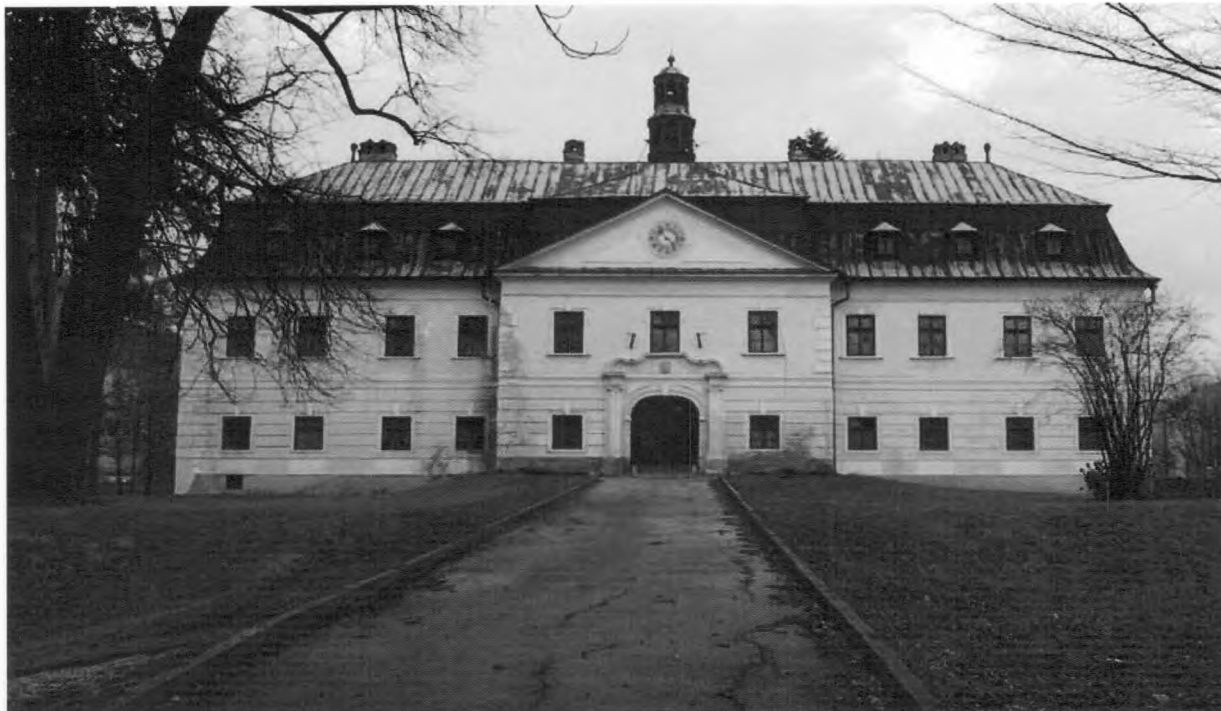
Budova pred rekonštrukciou
