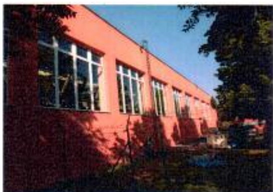
TN – rekonštrukcia fasády
