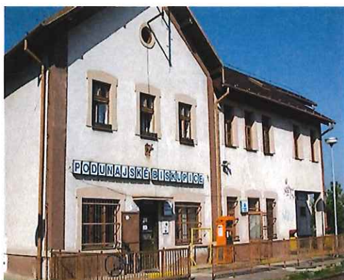
Budova železničnej stanice na Dvojkřížnej ulici
