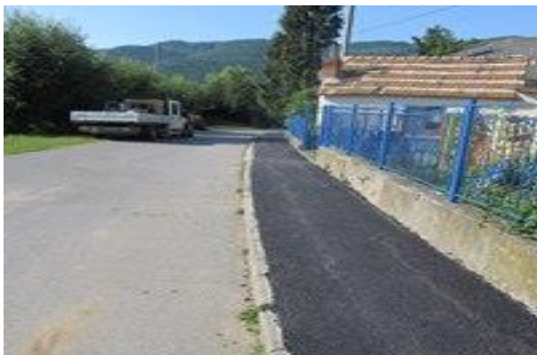
Rekonštrukcia chodníka na ulici Za Lutinkou
