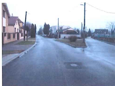
Posledná etapa rekonštrukcie Športovej ulice v dĺžke 391 m od Dlhej ulice po štadión bola ukončená v máji 2017 v hodnota 77 000 €
