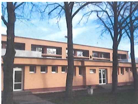
Rekonštrukcia strechy starej telocvične ZŠ J. A. Komenského vrátane zateplenia a výmeny okien stála 209 570,-- €, z čoho dotácia z Ministerstva školstva SR bola 104 660 €
