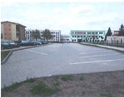
Parkoviská pre 52 vozidiel na Dolnomajerskej a Komenského ulici v hodnote 83 670,40 €
