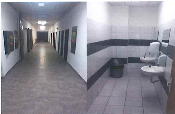
K predmetom rekonštrukcie vchodu do DK, prízemnia , vrátnice a skladu patrila aj rekonštrukcia chodieb a sociálnych zariadení
