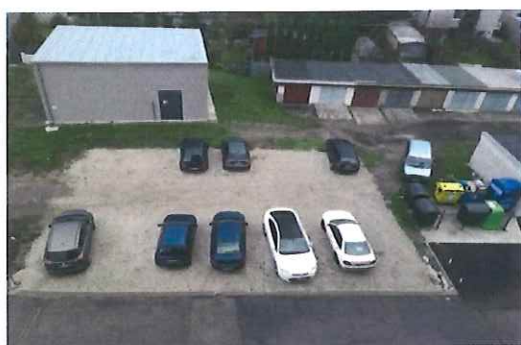
Spevnená plocha pri bytovom dome Cukrovárska 145/3 pre 12 vozidiel v hodnote 4 912,32 €
