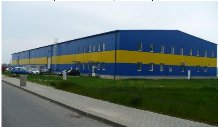
Výrobná hala LPH v Poprade - Matejovciach
