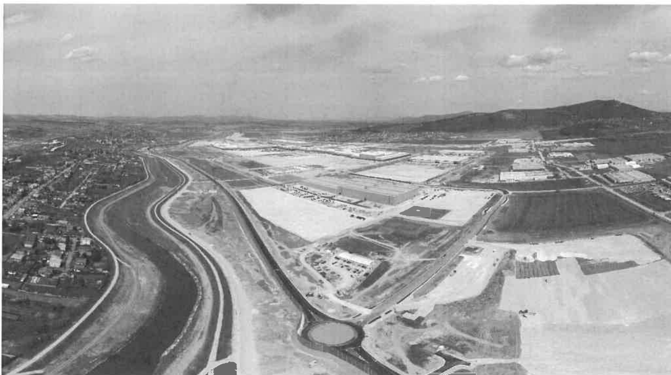
Príprava cestnej infraštruktúry – strategický park Nitra (letecká snímka stavby)
