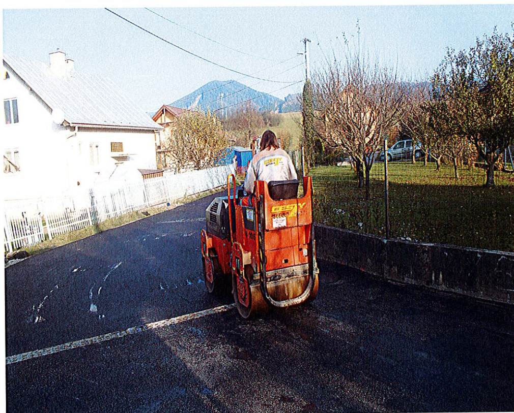
Zrekonštruovaná ulica Vršok
