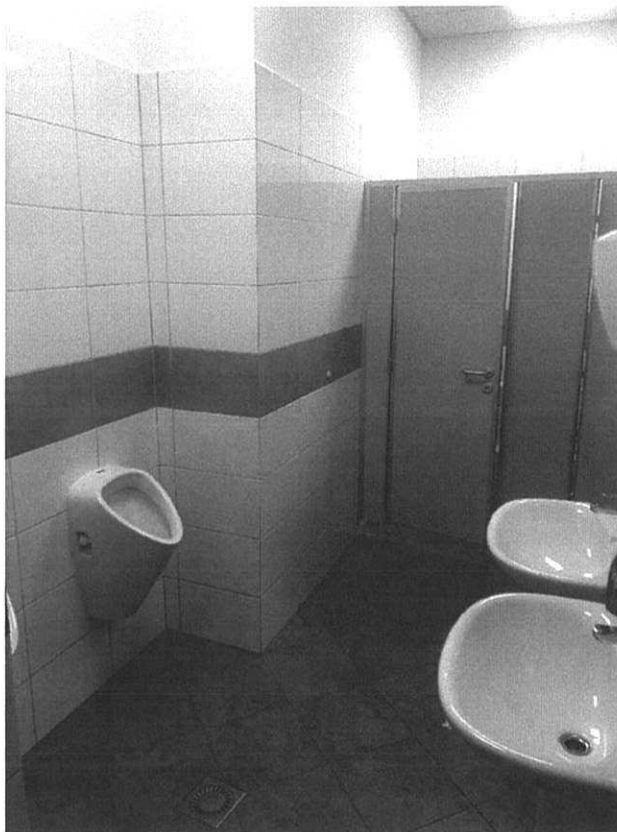
WC budova 3. 1. poschodie
