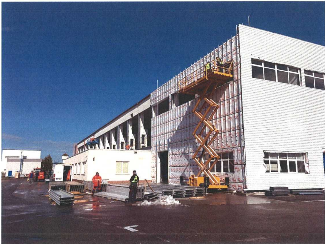
Rekonštrukcia fasády skladu 2.3
