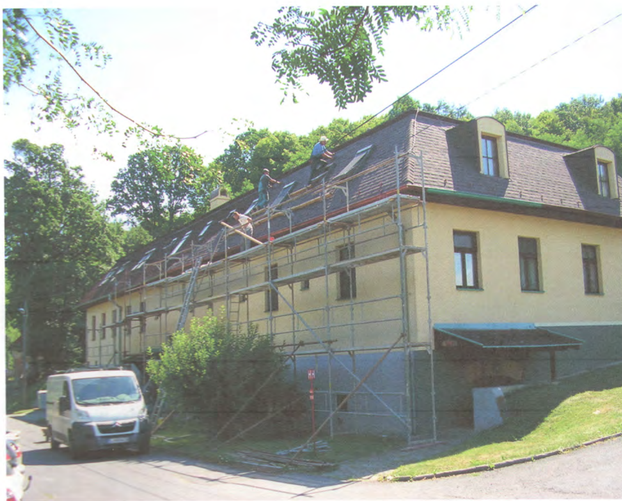
Oprava strechy – výmena strešnej krytiny
