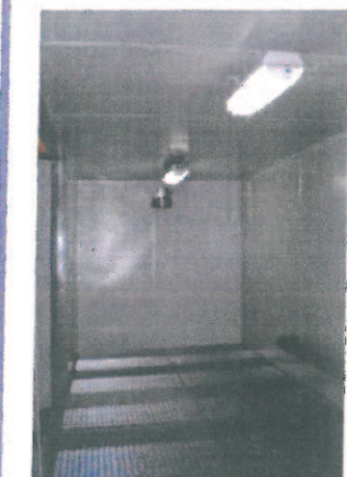
Environmentálny kontajner – izolovaný s elektroinštaláciou ATEX pre výbušné prostredie
