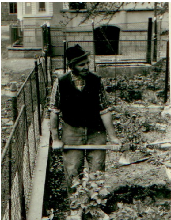
Bývalý dozorca cirkevného zboru Ondrej Kupec pri výstavbe novej fary
