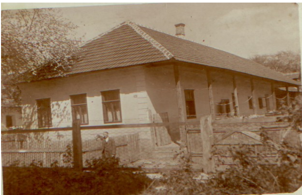
Stará fara Kocelovce, vpredu br. Farár Pošta
