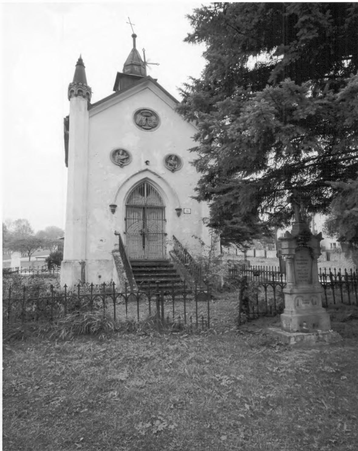
Kaplnka pred rekonštrukciou
