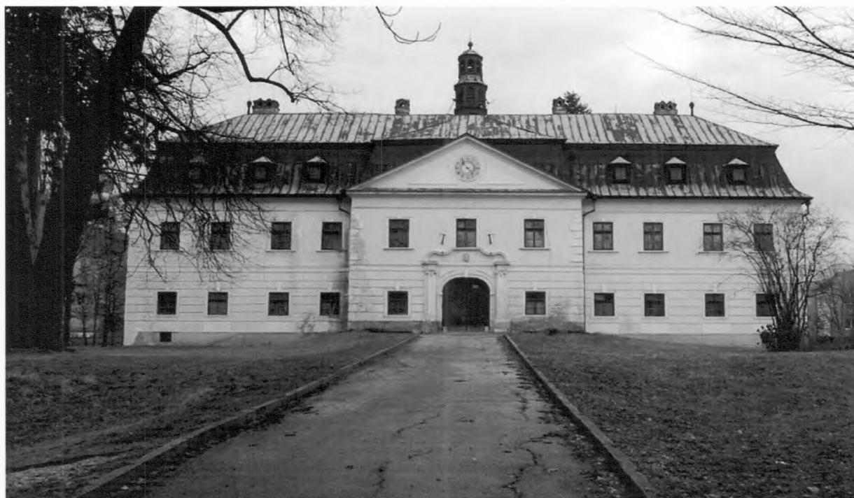
Budova pred rekonštrukciou
