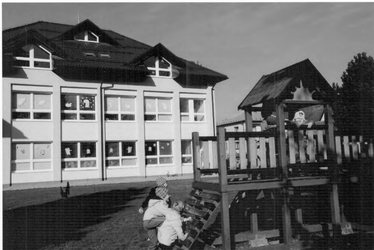
Budova MŠ po rekonštrukcii
