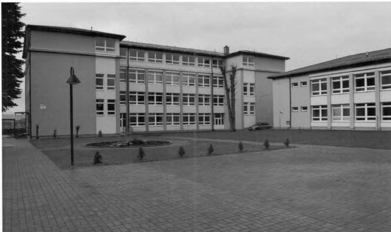
Budova ZŠ po rekonštrukcii
