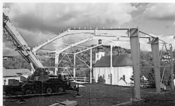
začiatok výstavby športovej haly v centre obce
