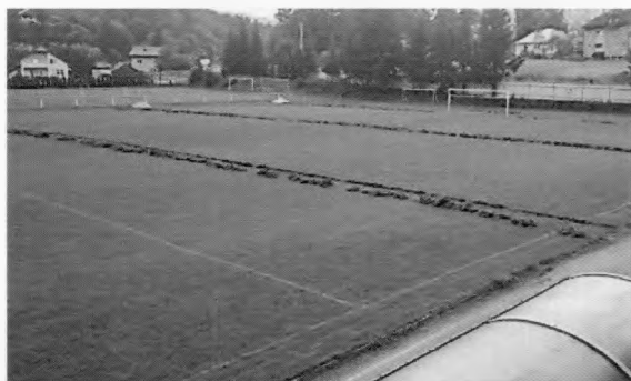
zavlažovací systém na futbalovom štadióne
