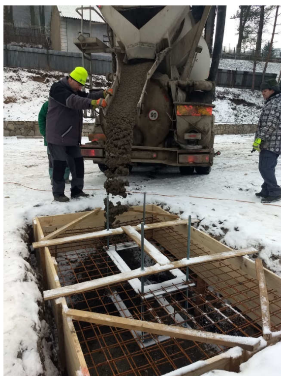
Prvá fáza výstavby skladových hál – betonáž základových pätiiek /Hala č.1/
