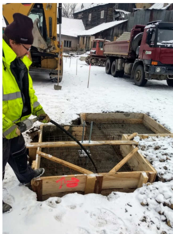
Prvá fáza výstavby skladových hál – betonáž základových pätiiek /Hala č.1/
