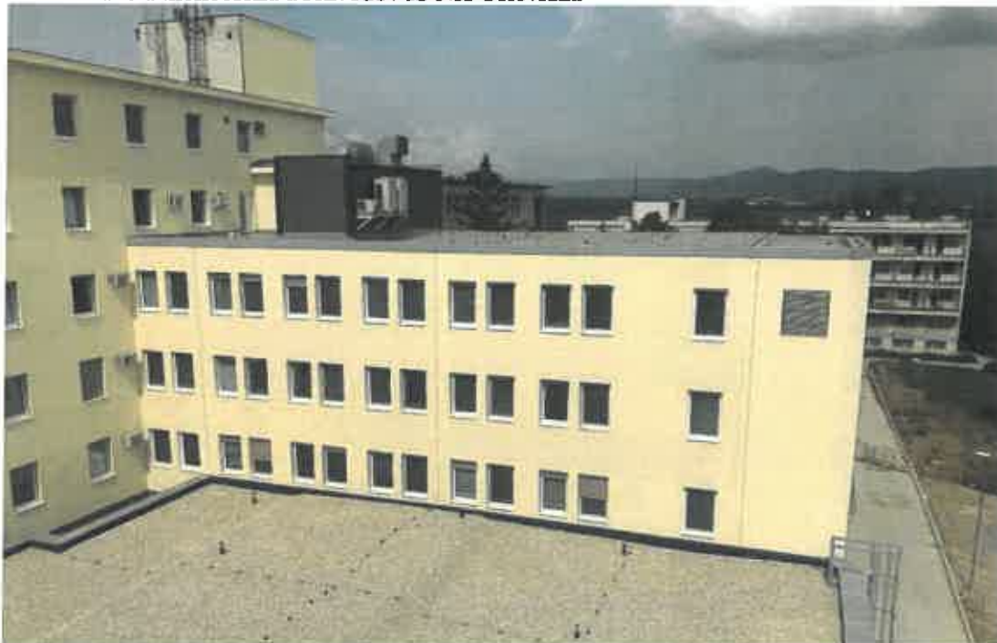
Rekonštrukcia monobloku a rozvodov IS NsP Prievidza
