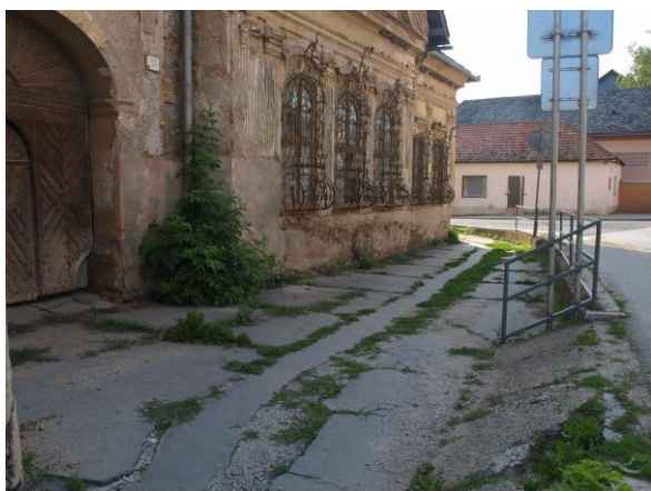
Chodník na Ochtinskej ulici pred rekonštrukciou
