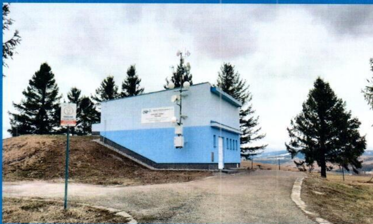
Zrekonštruovaný vodojem 1x250 m 3 Trstená
