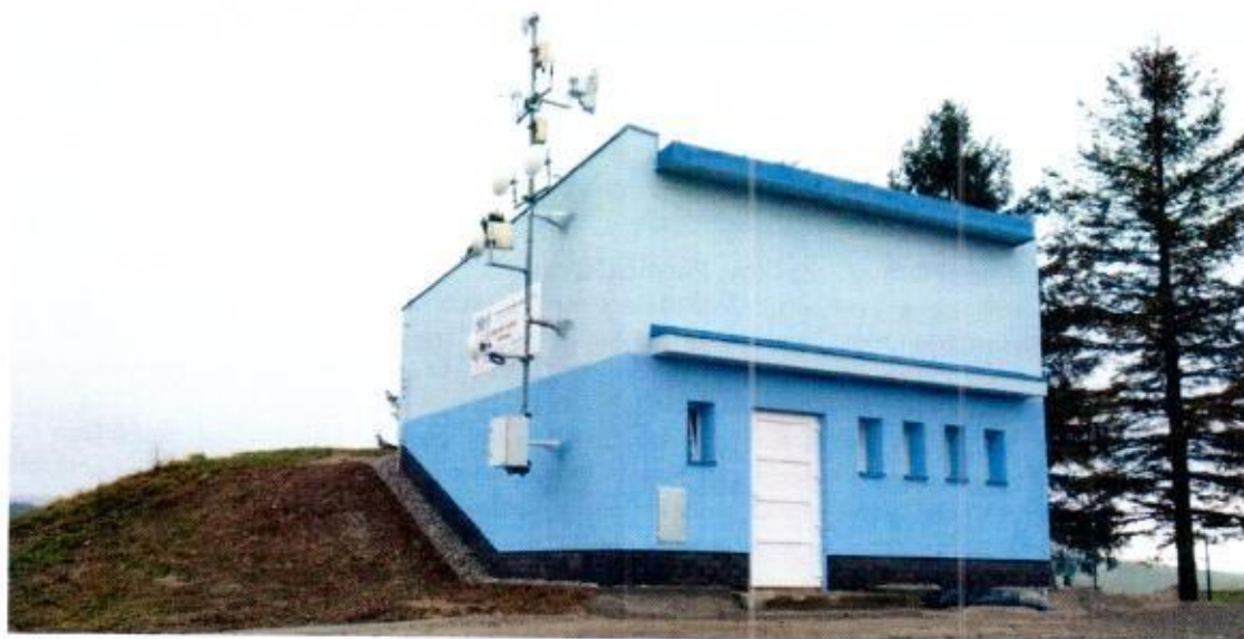
Zrekonštruovaný vodojem 1x250 m 3 Trstená
