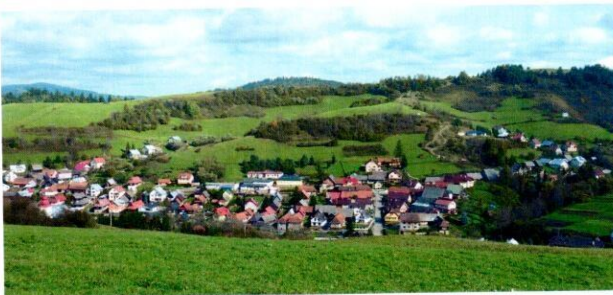
Panoráma obce Pribiš. Vpravo nad obcou vodojem 2x50 m 3
