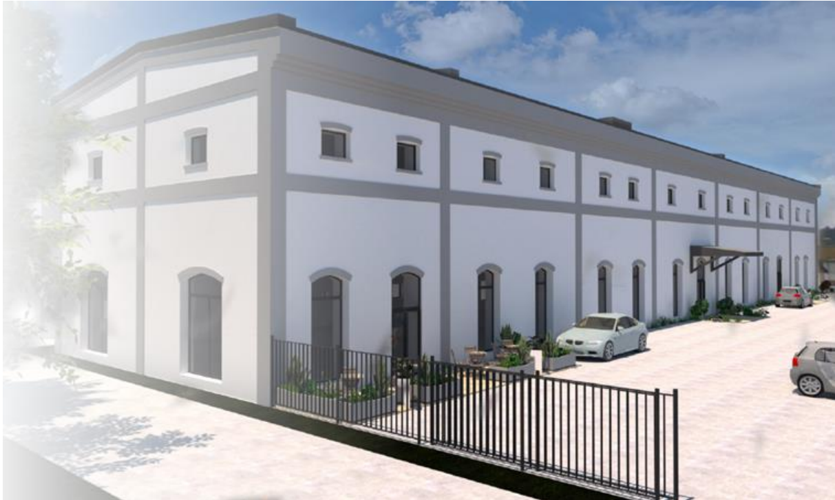
Objekt po rekonštrukcii
