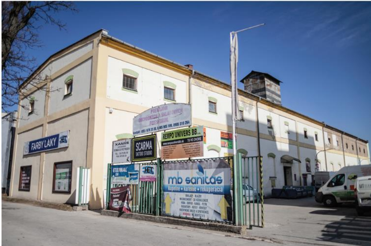
Objekt v pôvodnom stave pred rekonštrukciou
