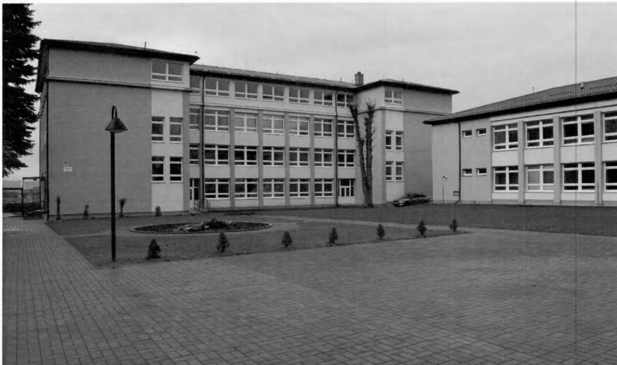
Budova ZŠ po rekonštrukcii
