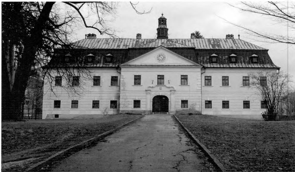
Budova pred rekonštrukciou
