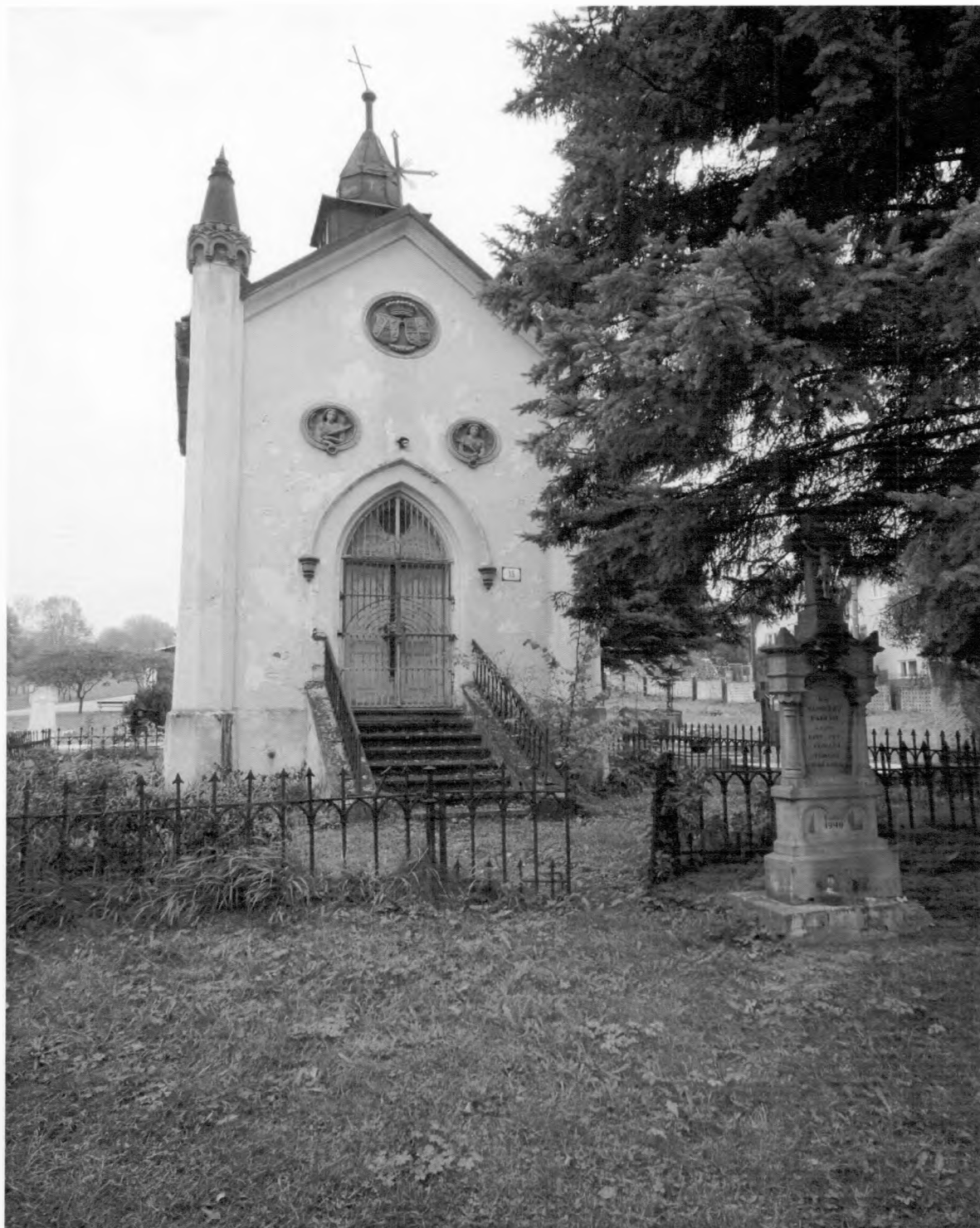
Kaplnka pred rekonštrukciou
