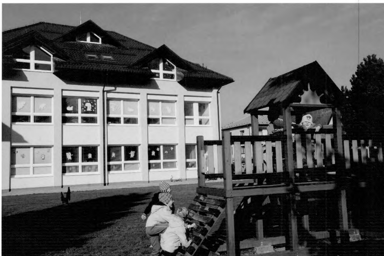
Budova MŠ po rekonštrukcii
