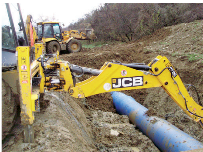
Nitrianske Rudno - oprava prívodného potrubia z VD Nitrianske Rudno počas prevádzky VS Nováky
