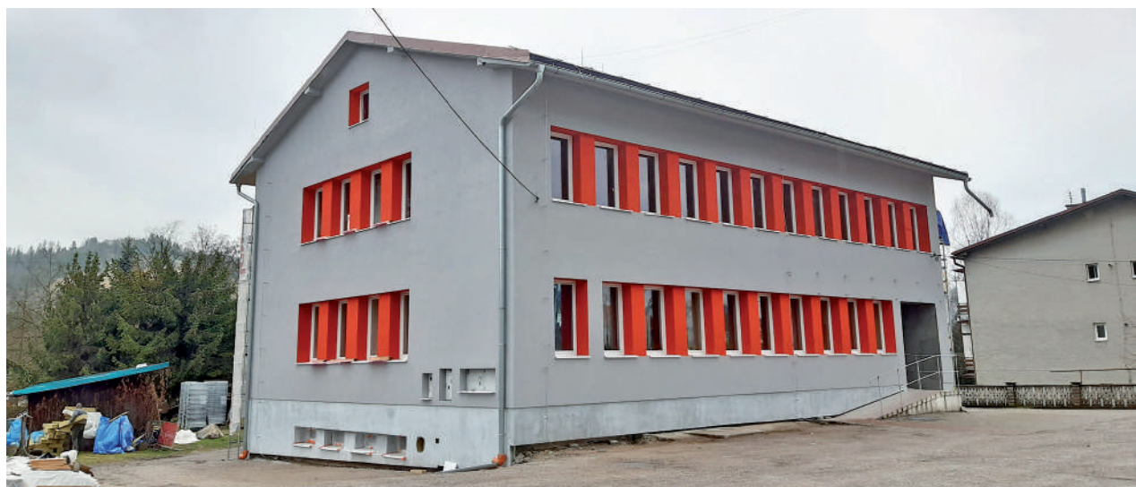
Obecný úrad Michalová - zníženie energetickej náročnosti
