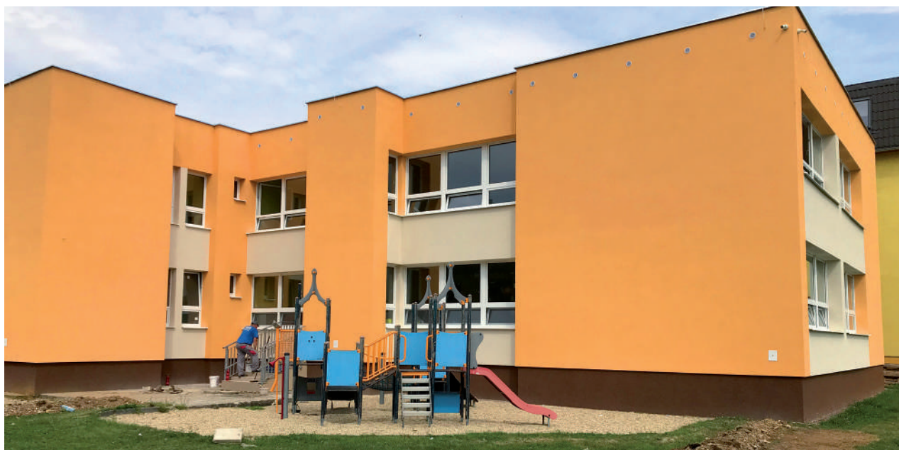
Moravské Lieskové MŠ - zateplenie objektu
