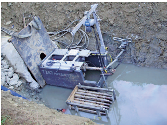
Nitrianske Rudno - oprava prívodného potrubia z VD Nitrianske Rudno počas prevádzky VS Nováky
