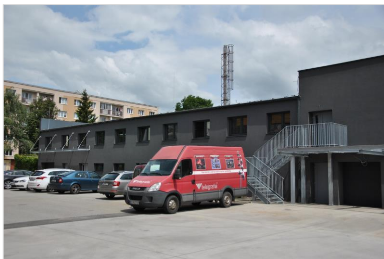
Nový vzhľad budovy – Lomená 7
