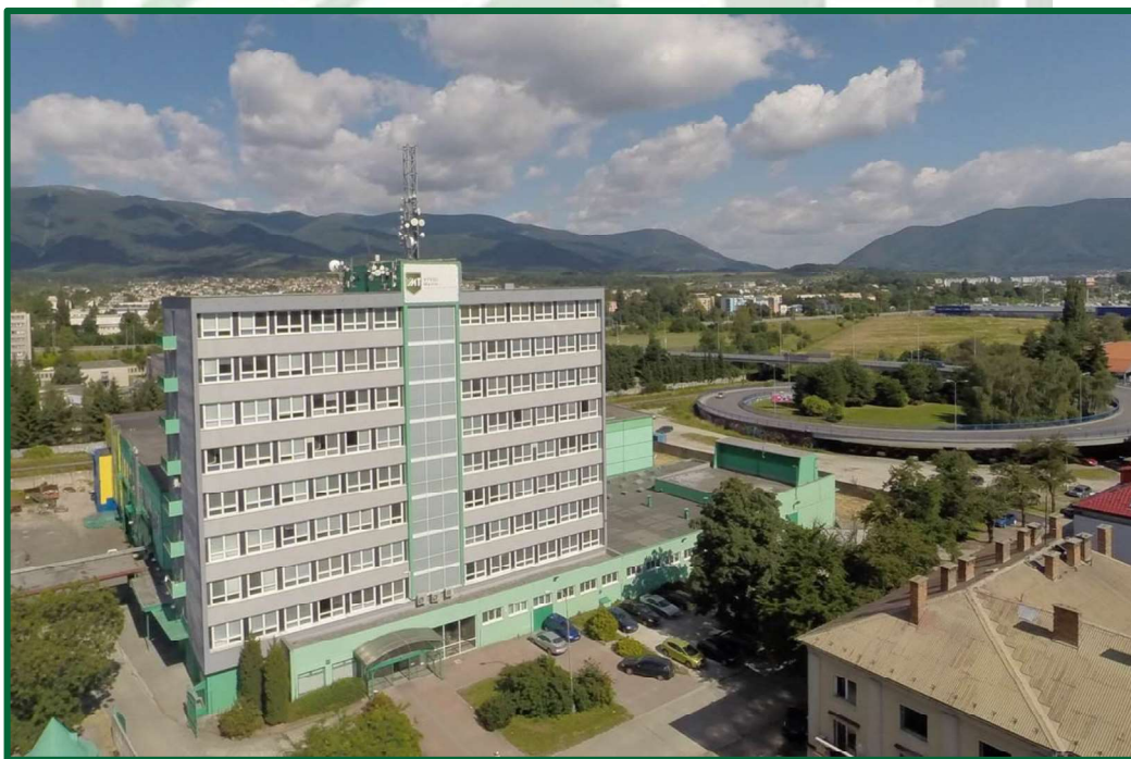
Pohľad na administratívnu budovu
