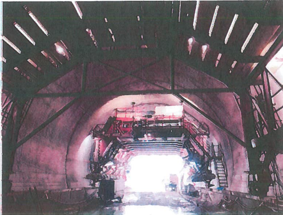
Tunel Diel – Betonáž sekundárneho ostenia tunela
