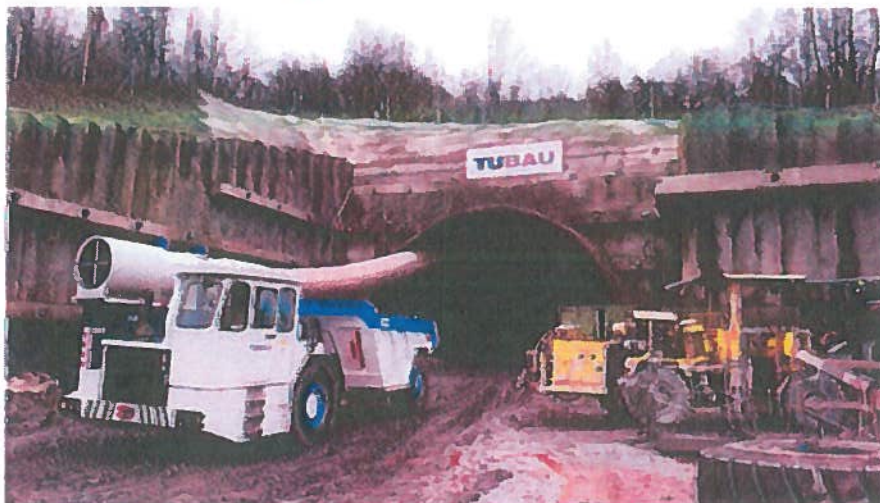
Západný portál tunela – raziace práce
