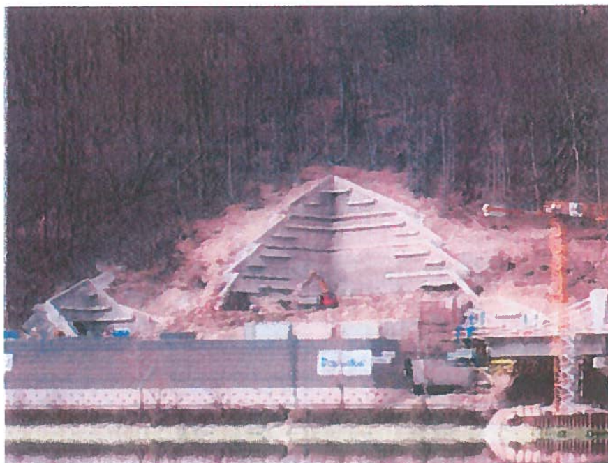
Východný portál tunela Diel
