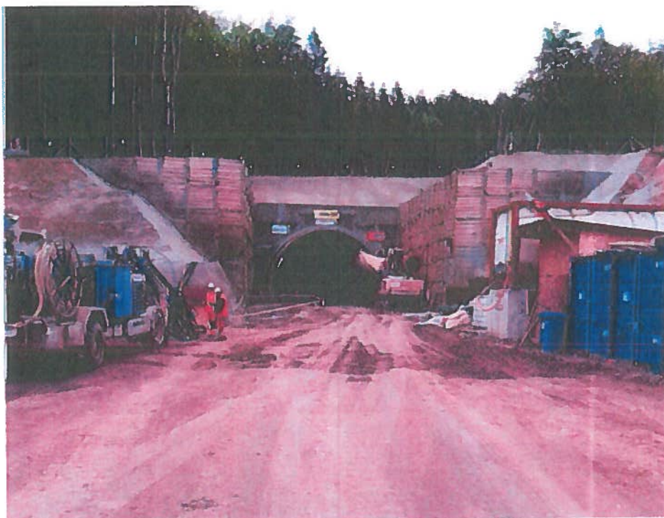
Výjazdový portál tunel Deboreč
