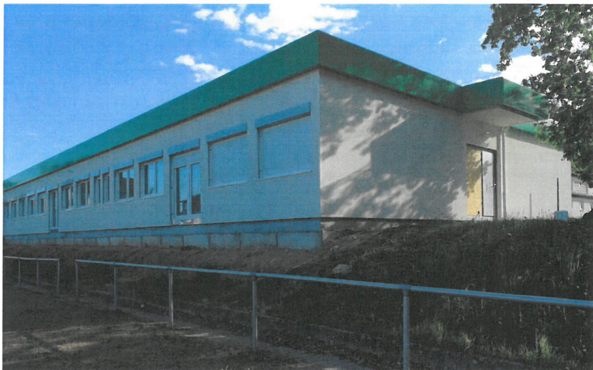
Materská škola Ostringen (Nemecko)
