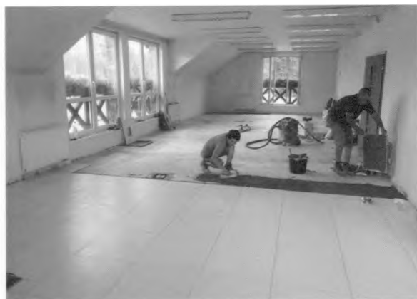
Oprava podlahy Obecného úradu
