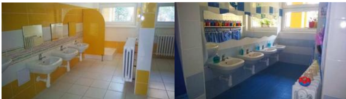
Rekonštrukcia sociálneho zariadenia
