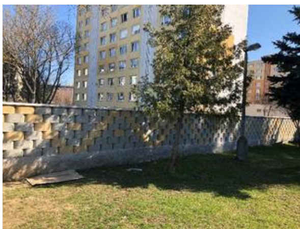
Rekonštrukcia časti oplotenia
