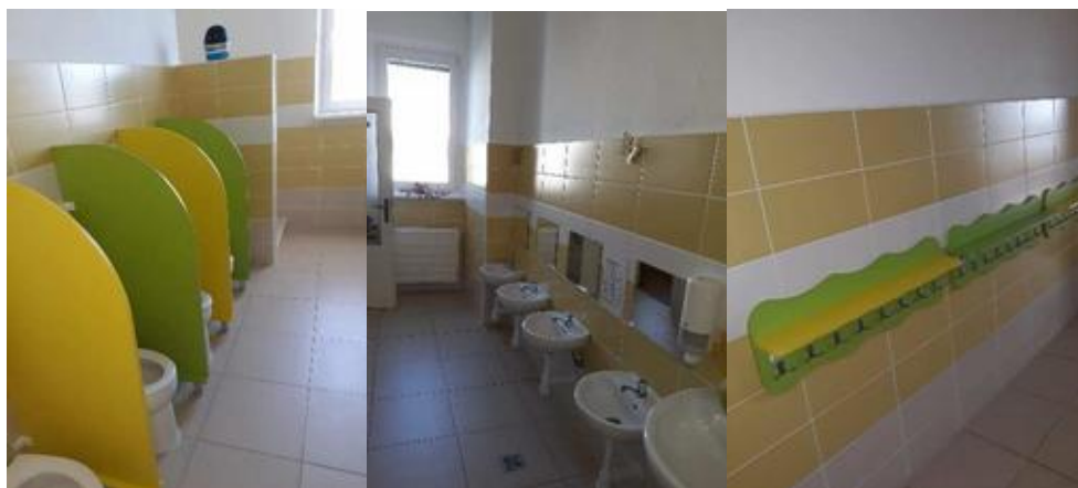
Rekonštrukcia kúpeľne MŠ
