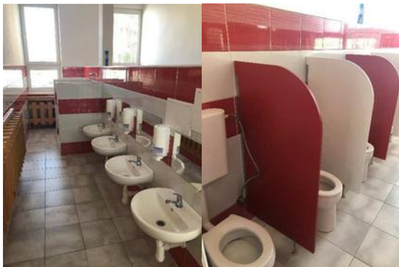
Rekonštrukcia sociálneho zariadenia
