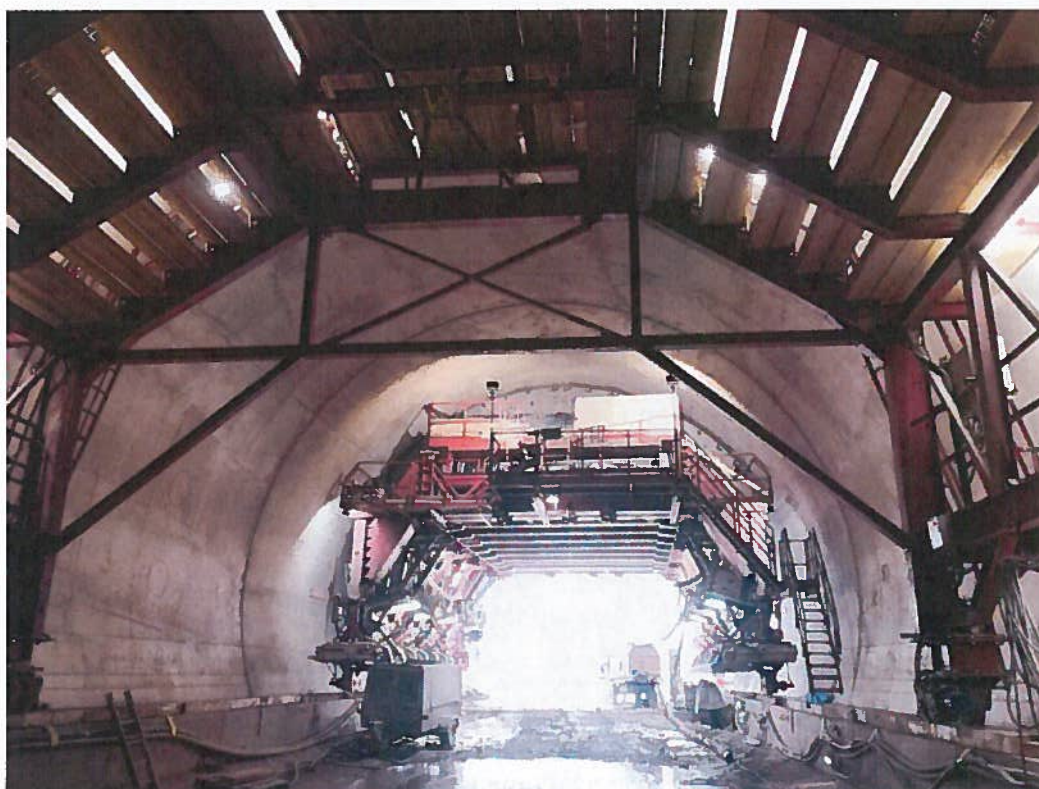
Tunel Diel – Betonáž sekundárneho ostenia tunela
