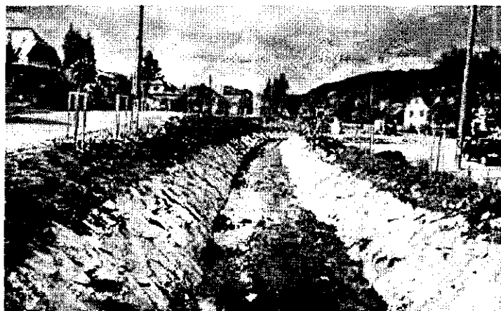
Stavba: "Ochrana pred povodňami"
