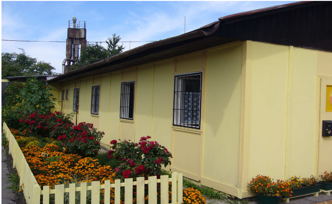
Prevádzková budova KRUH, n. o.
