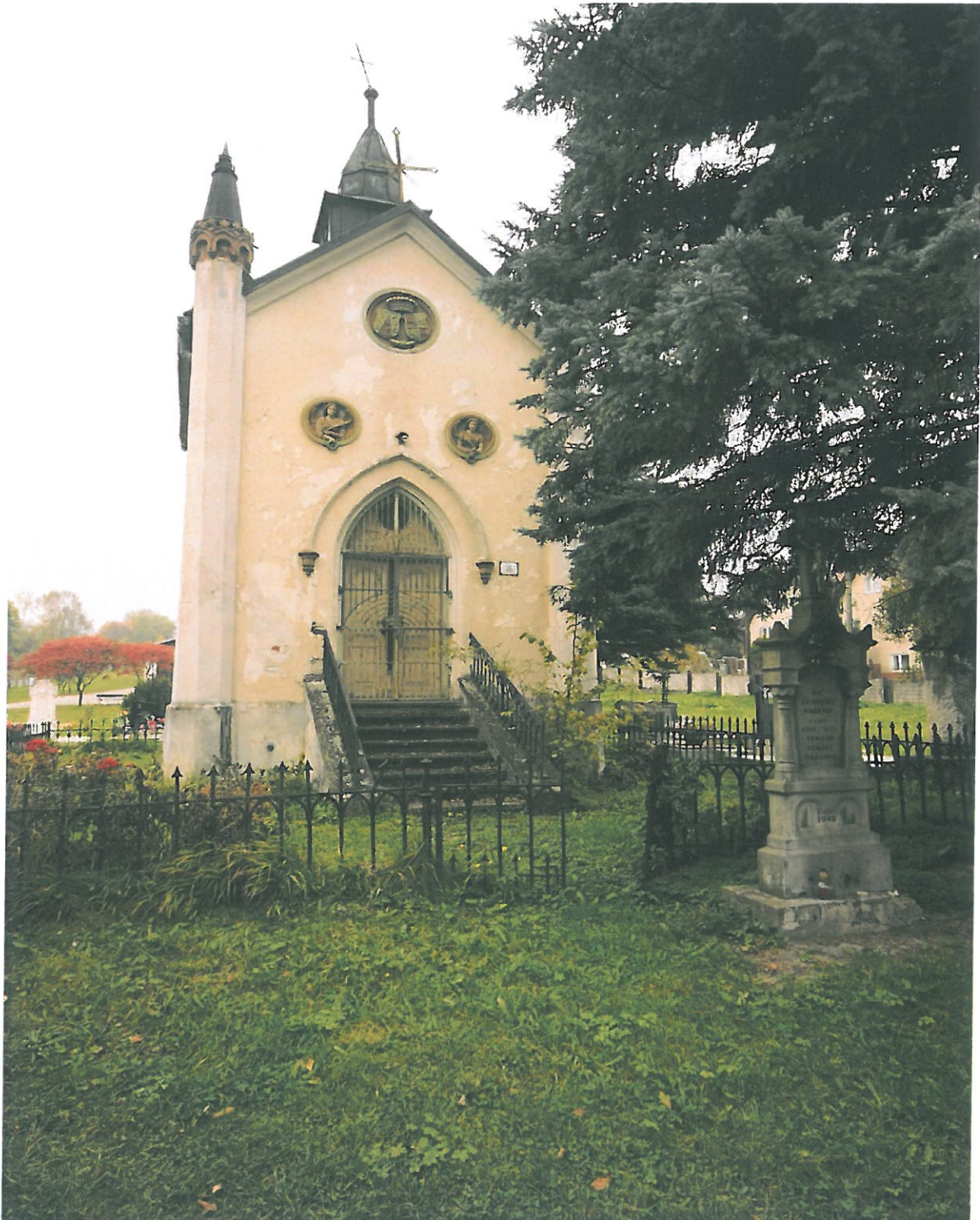
Kaplnka pred rekonštrukciou
