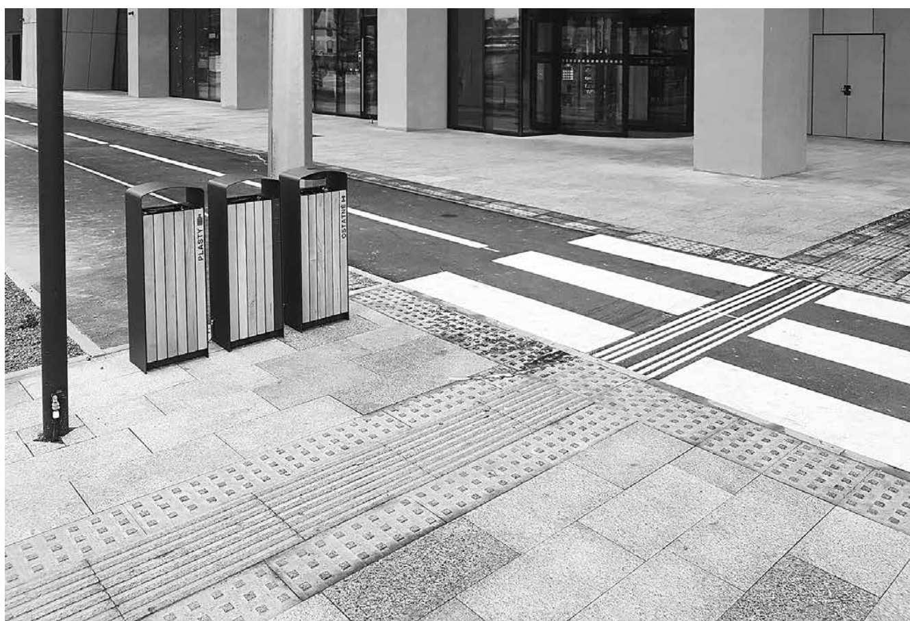
Kríženie pešej trasy a cyklistickej cestičky s priechodom pre chodcov, s varovným a signálnym pásom.
