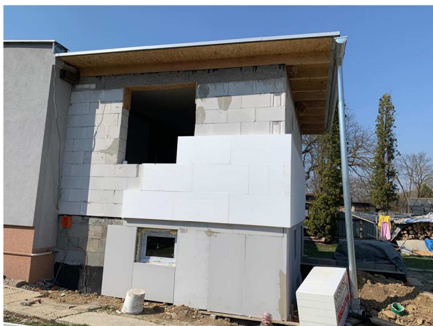
Rozširovanie kapacity zariadenia
