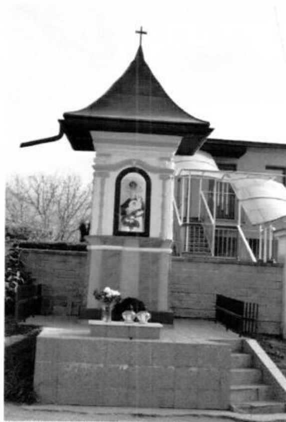
Obnovená kaplnka v roku 2018
