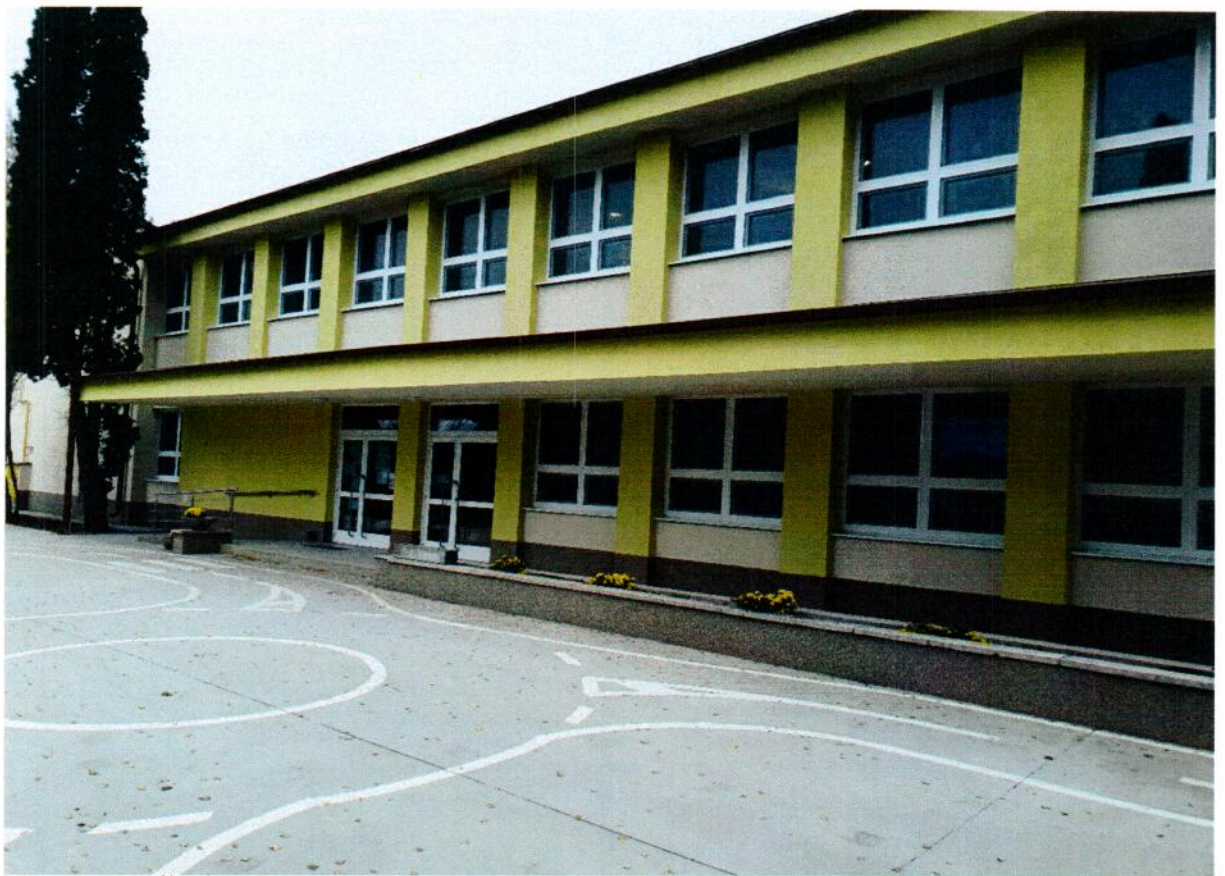
budova MŠ po rekonštrukcii- západný pohľad
