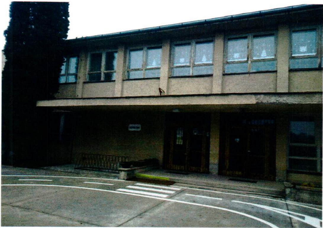
Budova MŠ pred rekonštrukciou
