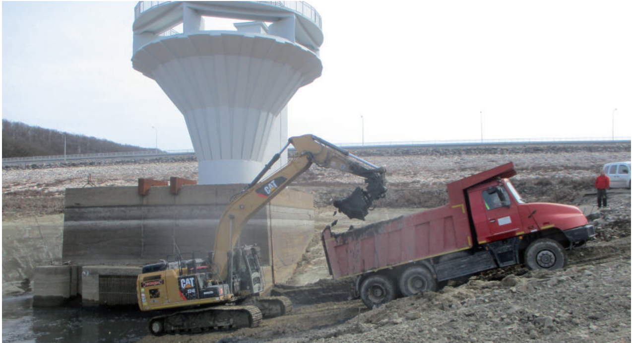
VS Ružiná, oprava objektov
