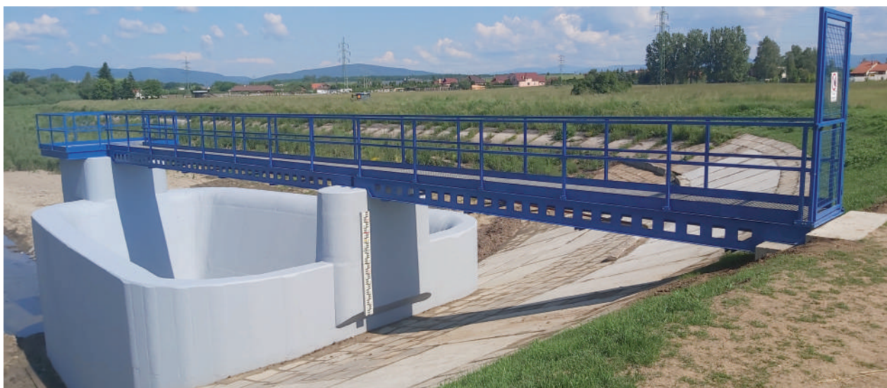
VD Ľadovo, rekonštrukcia bezpečnostného priepadu
