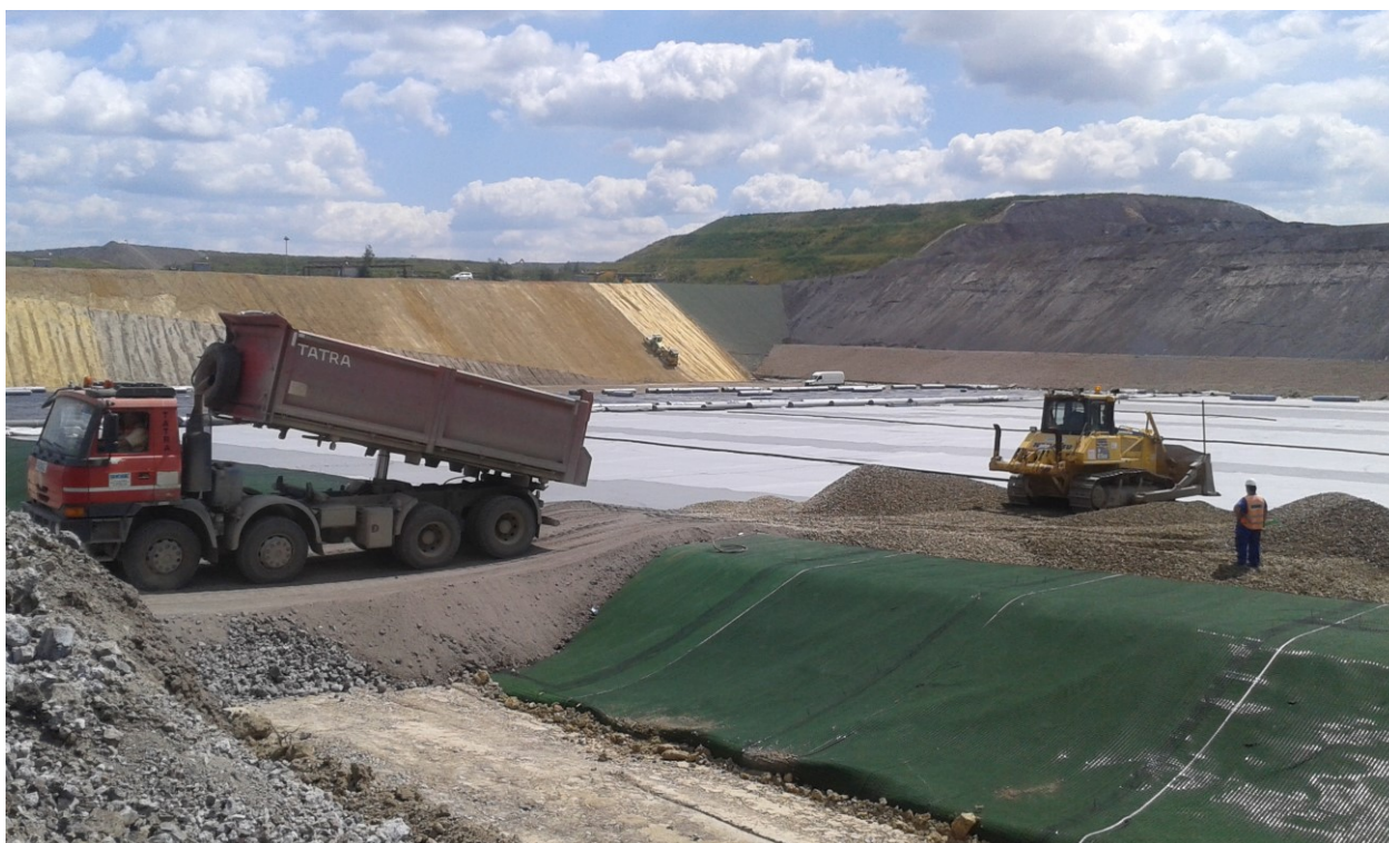
stavebné práce na stavbe 1337BL Skládka nie nebezpečného odpadu 4 etapa
