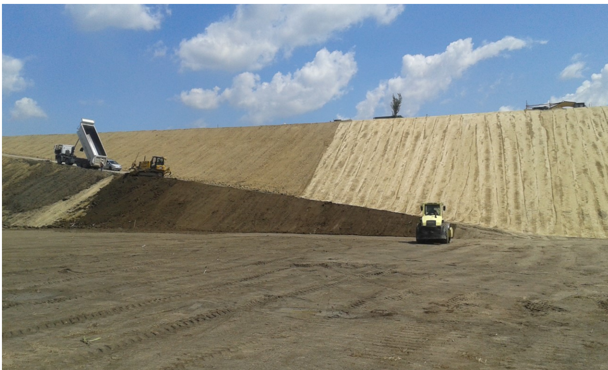
stavebné práce na stavbe 1337BL Skládky nie nebezpečného odpadu 4 etapa
