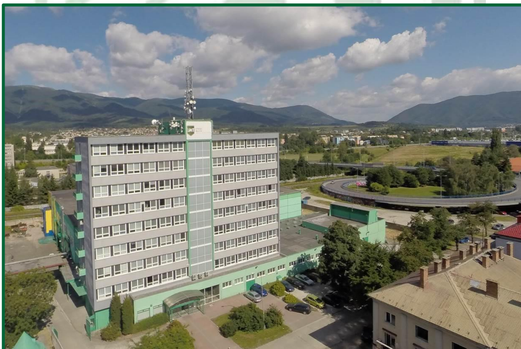
Pohľad na administratívnu budovu
