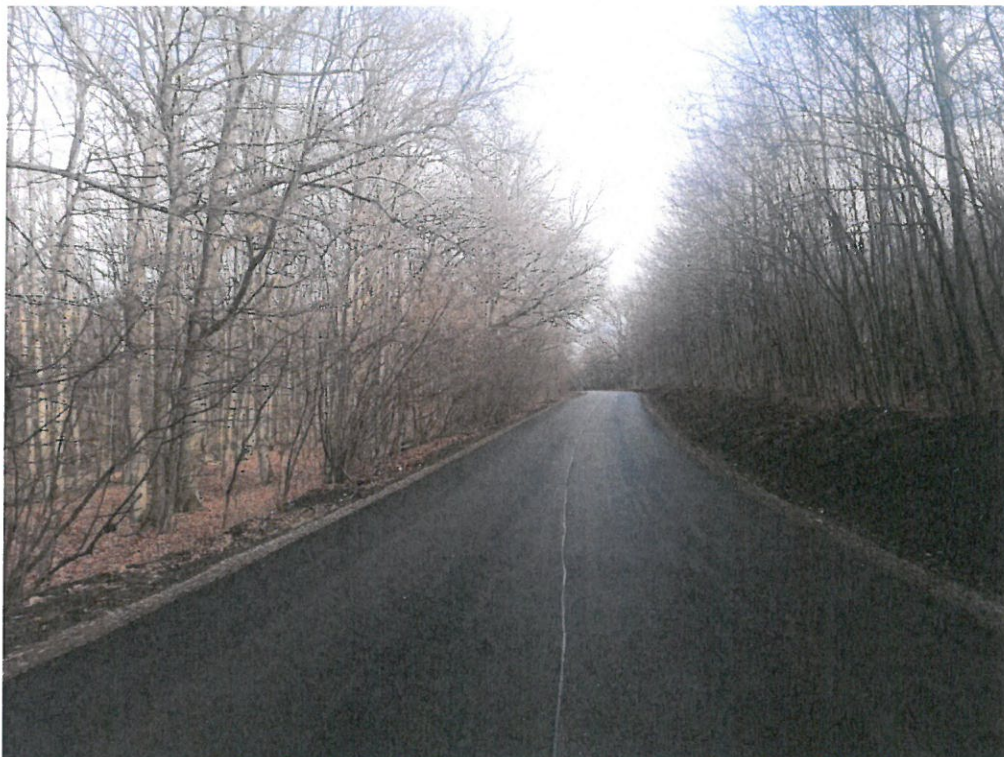
Obrázok 9: Rekonštrukcia cesty III/3440 Rozhanovce – Čížatice vrátane priepustu
