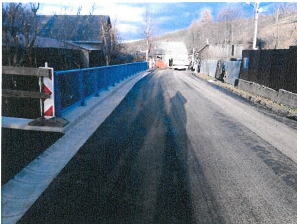
Obrázok 10: Stabilizácia cesty III-3110 Malá Franková – úsek III.
