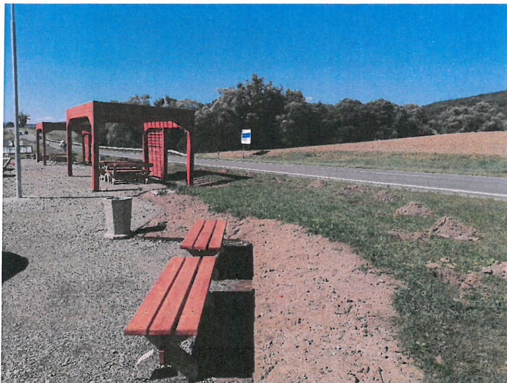
Obrázok 3: Výstavba odpočívadla na ceste II/545 Kľušov
