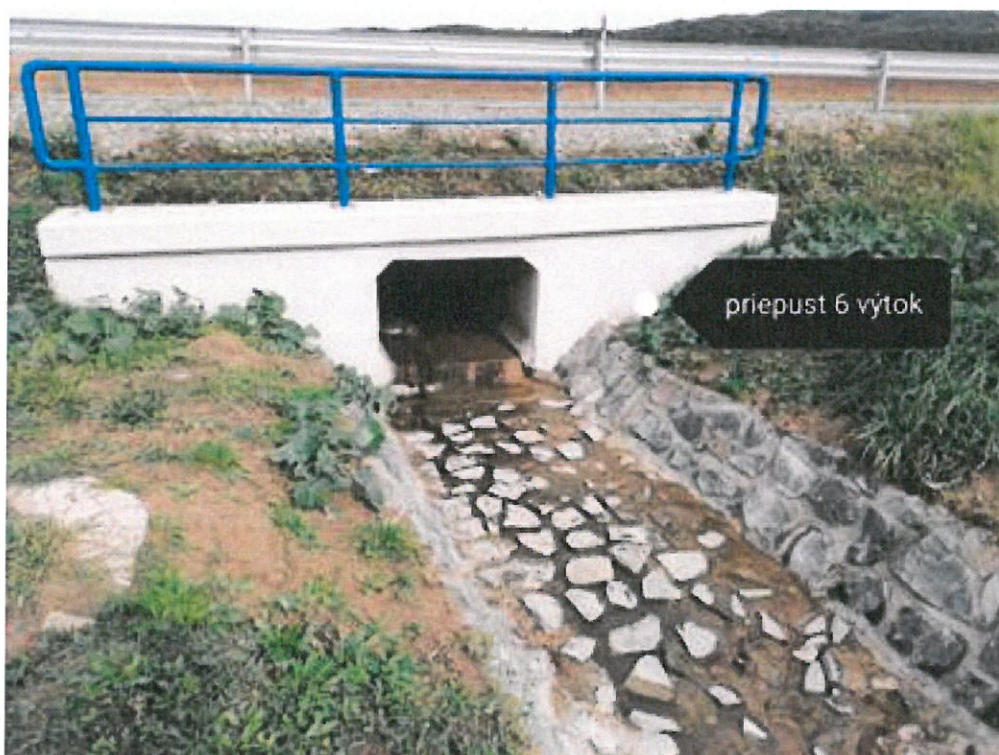
Obrázok 8: Rekonštrukcia cesty II/545 Janovce - Kľušov
