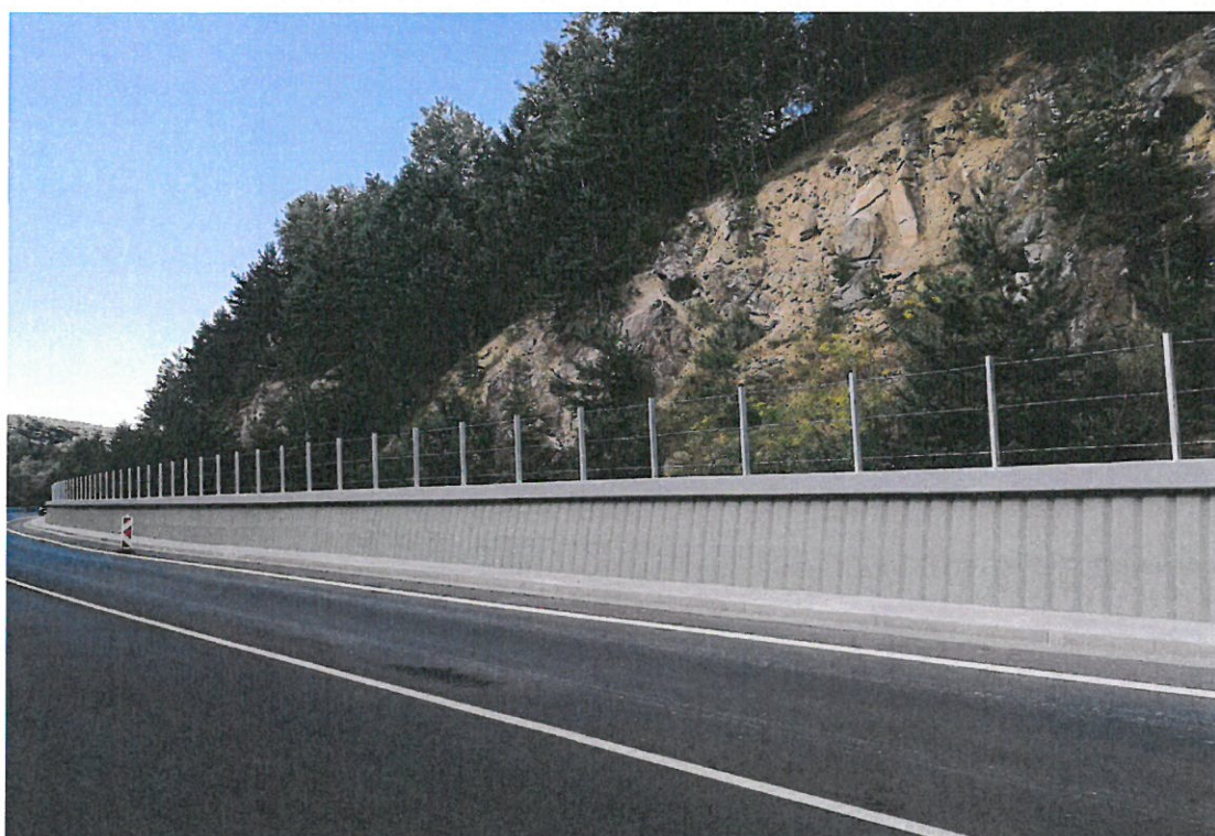
Obrázok 2: Rekonštrukcia oporných múrov na ceste II/545 Demjata
