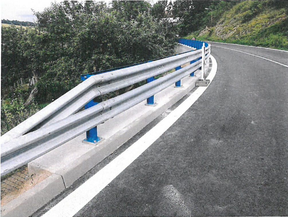
Obrázok 5: Modernizácia cesty II/546 Prešov-Klenov /Oporný múr v obci Žipov/
