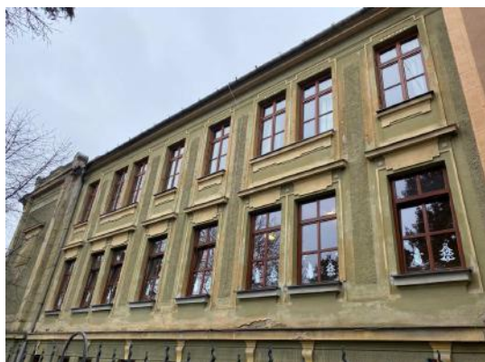
Výmena okien/poschodie, Ul. Šrobárova/
