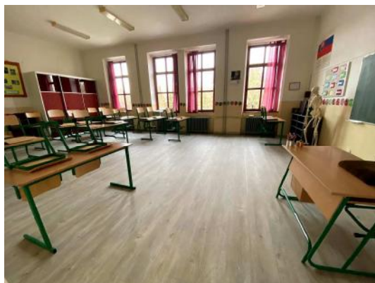
Výmena podlahovej krytiny /trieda na poschodí, Ul. Šrobárova/
