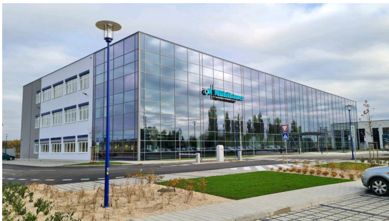
Foto: Muehlbauer Automation s.r.o. Nitra.
