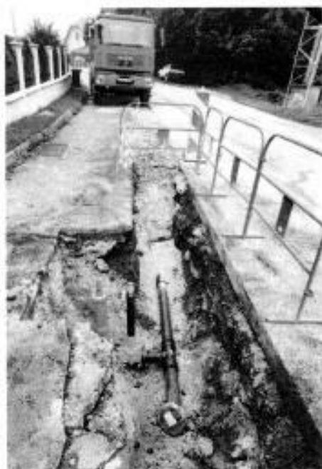
Rekonštrukcia vodovodu v obci Osádka.
