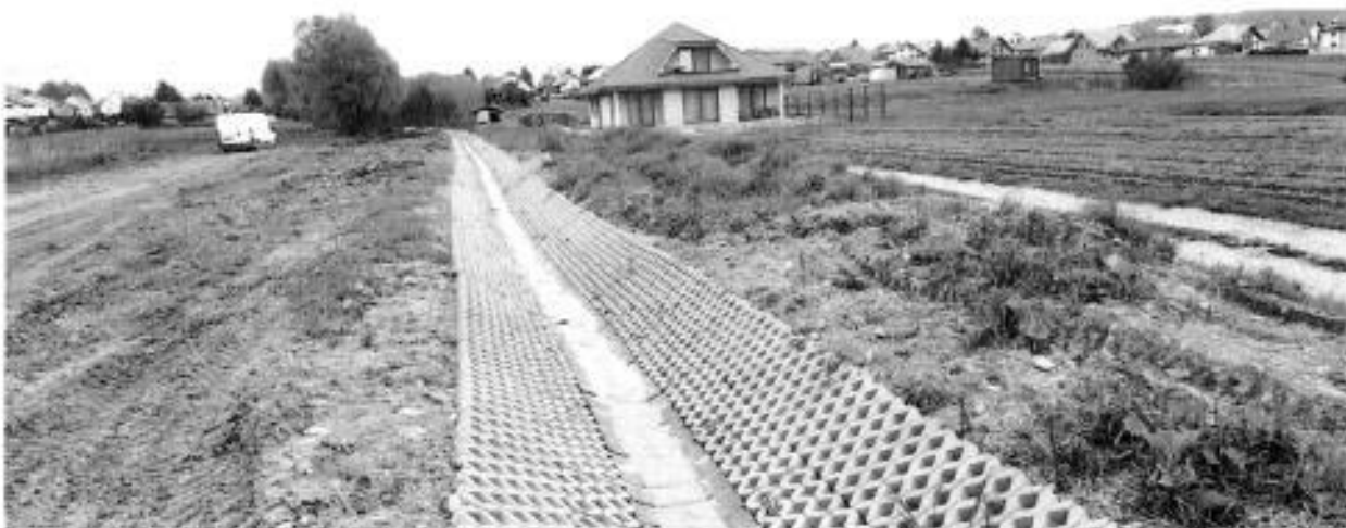
Rabča oprava toku - V zmysle požiadaviek vlastníkov pozemkov bola vykonaná úprava toku popri kanalizačnej vetve „P“ v rámci projektu Orava II.
