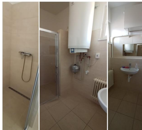
prerobená kúpeľňa so sprchovým kútom
