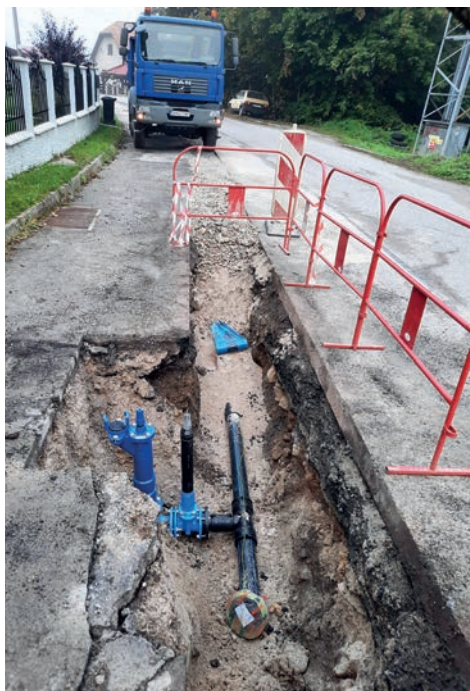
Rekonštrukcia vodovodu v obci Osádka.
