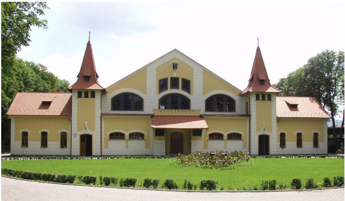
Foto 1: Historická budova jazdiarne.
