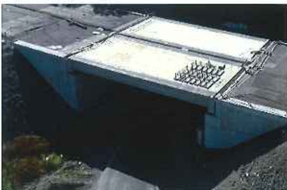
Most na R2 nad Budínskym potokom v km 15.870
