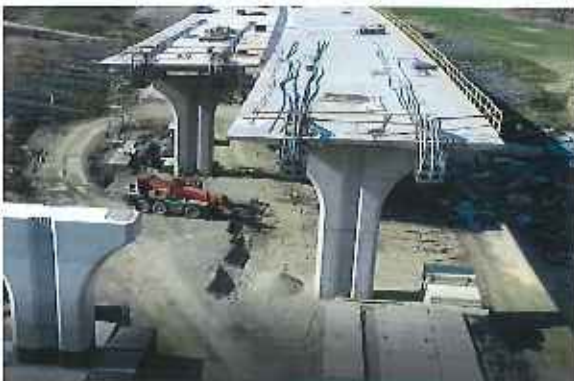
Most na R2 nad žel. traťou a cestou I/16 v km 9,441 - 9,957
