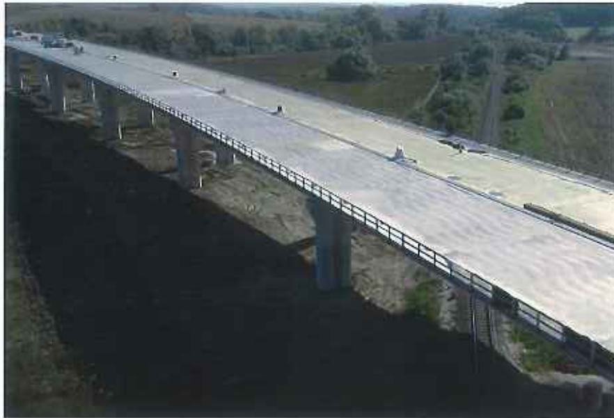
Obr. 17 Most na R2 nad žel. traťou a Krivánskym potokom
