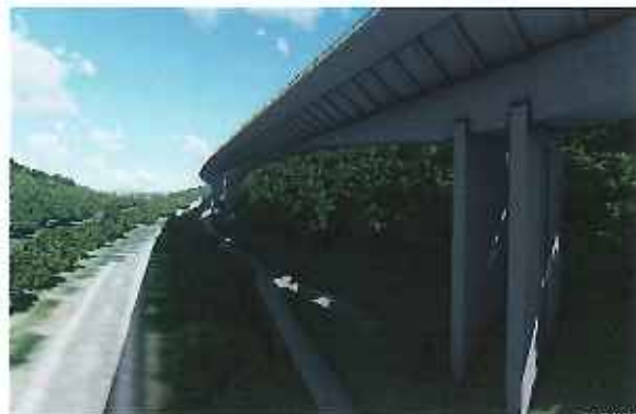
Vizualizácie dilatáčného celku stavaného letmou betonážou
