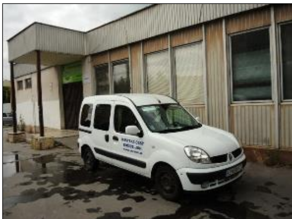
Obr. 21 Jedáleň pre dôchodcov, Vojvodská 5 pôvodný stav
