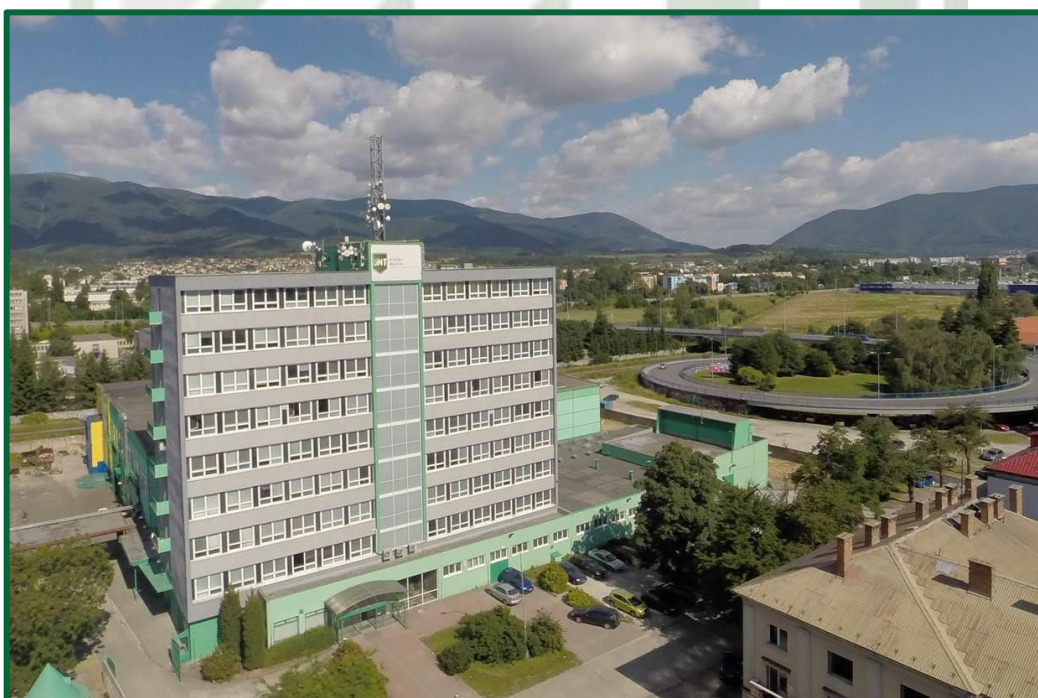
Pohľad na administratívnu budovu
