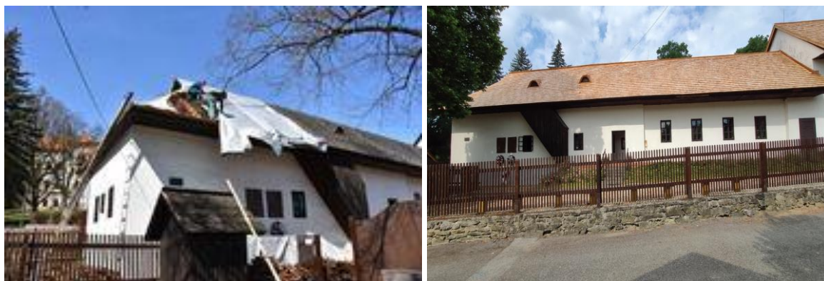
Katov dom na Matúšovej ulici v Trenčíne – výmena strešnej krytiny a drevenej ochodze
